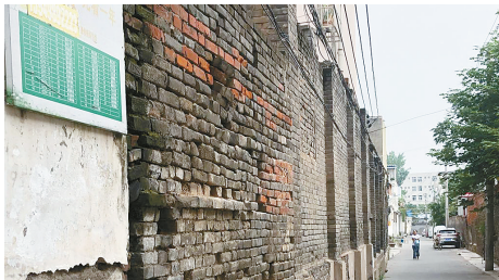
黄河路西段忠义街，墙体老化，砖块有脱落危险。
