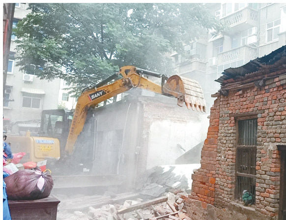
6月17日,源汇区城市发展服务中心马路街中队联合马路街办事处对化工厂家属院的15处违章建筑进行拆除。 本报记者 朱红 摄
