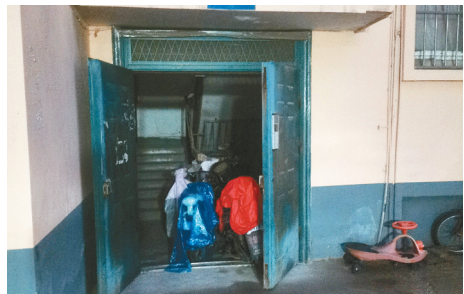
漓江路盛隆阳光名邸小区1号楼1单元，几辆电动车长期占据消防通道。
