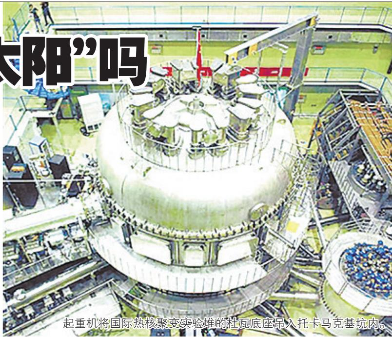
起重机将国际热核聚变实验堆的杜瓦底座吊入托卡马克基坑内。
