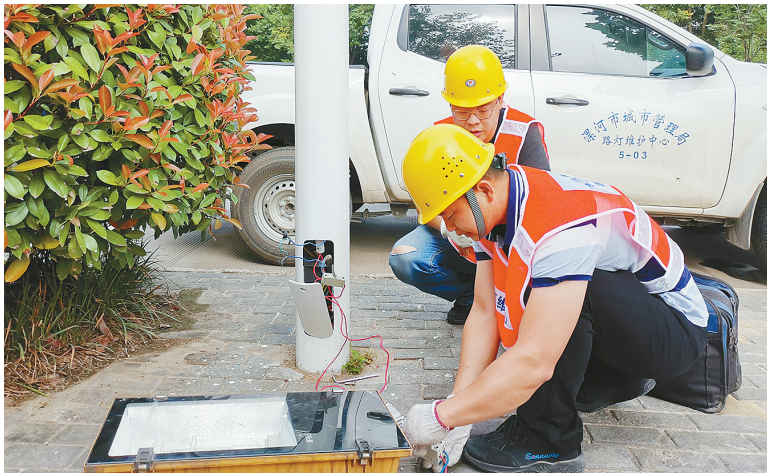
日前,市城市管理局路灯维护中心在市区安装了372台路灯电缆漏电报警系统终端。终端设有漏电保护装置,确保路灯电缆在积水中或下雨时不会漏电伤人。图为技术人员现场测试电缆漏电报警系统终端。
