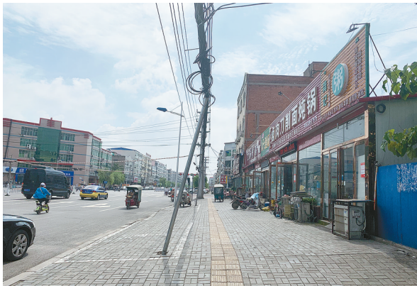
7月13日，记者在市区辽河路与井冈山路交叉口西南角看到，支撑线缆的线杆倾斜，存在安全隐患，希望有关部门及时整治。 见习记者 李博昊 摄
