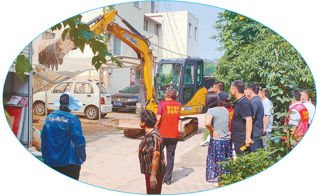
7月20日，郾城区龙塔街道巴山路社区联合区城市管理综合执法大队，对沙澧文景苑小区内私搭乱建进行拆除。 本报记者 姚晓晓 摄
