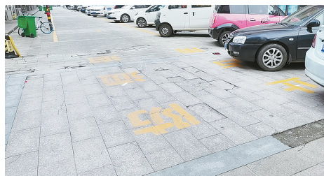
MOCO新世界美食步行街地面坑洼、地砖破损。
