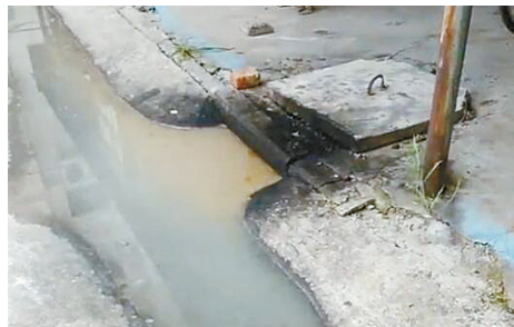
天泰景艺苑4号楼与5号楼临街门面房下水道堵塞。
