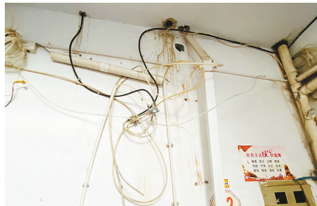
阳光世纪苑一期17号楼1单元，各类线路乱七八糟。
