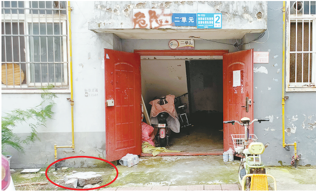
8月4日上午,太行山路北段宏源新城小区3号楼二单元楼道口外檐水泥块脱落。小区物业公司负责人王先生表示,他们会尽快拿出维修方案。 见习记者 刘净旖 摄
