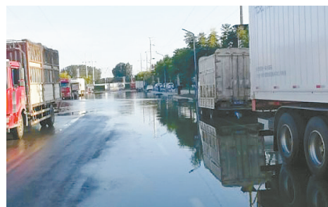
经济技术开发区桐柏山路污水漫溢，市民过往不便。
