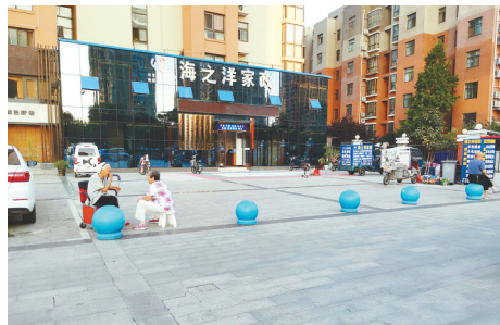
银河湾小区西门口，有人设置大石墩占停车位。
