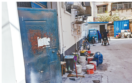
舟山路66号院，进出通道及院内堆放粉刷物料半月之久，影响居民通行。
