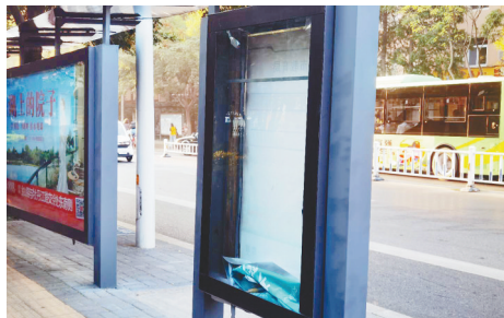
市教育局西侧公交站点，公益广告牌破损。
