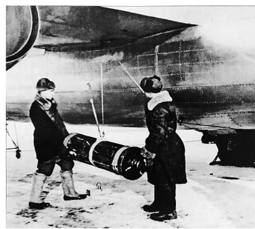
为缩短起飞滑跑距离,一些军用飞机可在机身上加挂火箭助推器(如上图),实现短距起飞。
