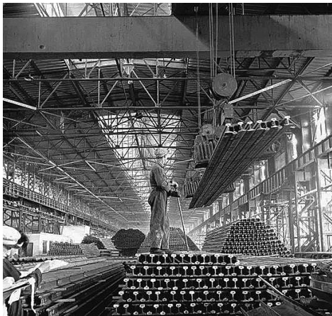
“一五”期间，鞍钢兴建的第一座大型轧钢厂生产能力迅速超过设计标准。
