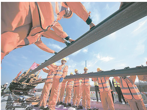
2019年4月15日，京雄城际铁路（北京段）开始正式铺轨，9月开通运营。
