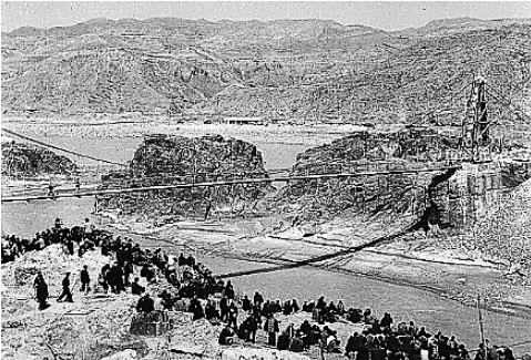
1957年4月13日,举国瞩目的治理和开发黄河的三门峡水利枢纽工程正式开工了。
