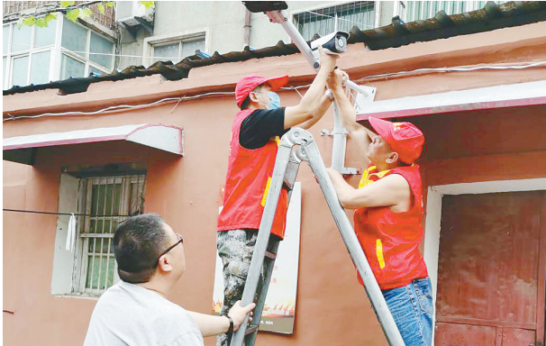
近日，市城投集团组织志愿者到“三无”楼院水厂家属院开展整治活动。图为志愿者正在安装监控设备。 本报记者 陶小敏 摄
