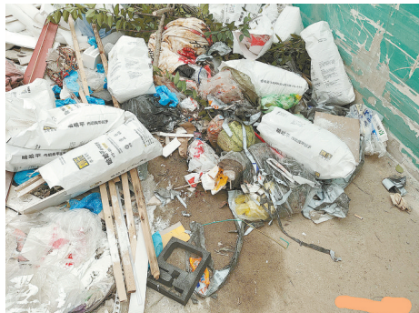
金山路御园小区,地下车库变成了垃圾场。
