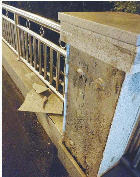
嵩山路沙河桥北段西侧，桥墩大理石贴片掉落、破损。
