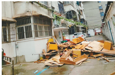
黄河路工会家属院居民装修，高空抛物，有安全隐患并影响居民出行。
