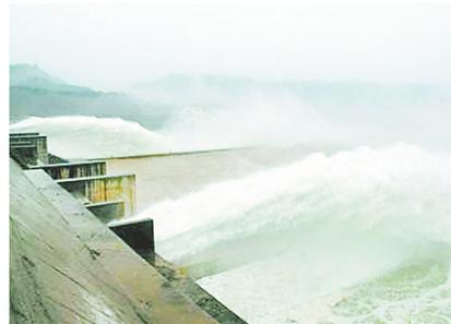
2002年7月4日,水利部黄河水利委员会在小浪底水库对黄河进行首次调水调沙试验,主要解决黄河的泥沙淤积问题。这是世界水利史上最大规模的人工试验。
