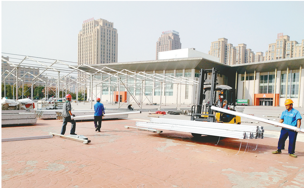
工人正在搭建食博会室外展棚。
