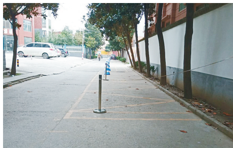
交通南路叔重幼儿园南校区门前，消防通道被占用，导致路面很窄，通行不便。
