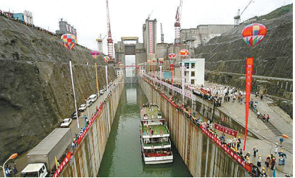
1998年5月1日，三峡工程临时船闸正式通航。
