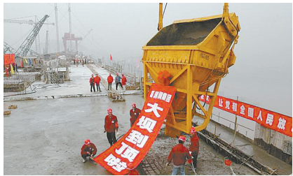
2002年10月26日，全长1600多米的三峡工程二期大坝全线封顶，达到185米的设计高程。
