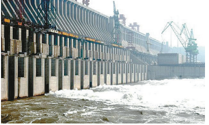
2003年6月1日，三峡工程正式下闸蓄水。
