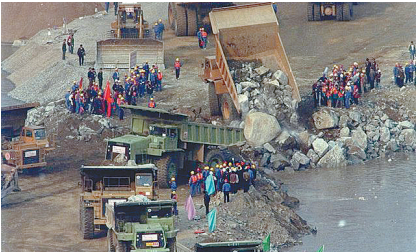
1997年11月8日，三峡工程实现大江截流，标志着为期5年的一期工程胜利完成，三峡工程转入二期工程建设。
