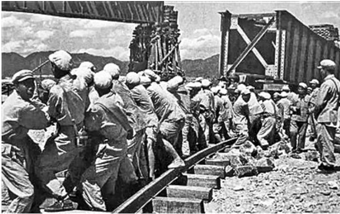
铁道兵冒着敌机轰炸架起被炸塌的钢梁。
