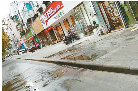
柳江路与太行山南路交叉口向东约50米路南，居家小铺门前，下水道堵塞。
