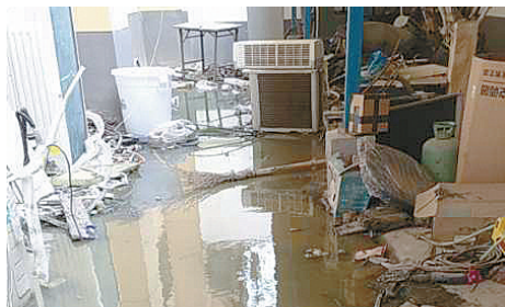
人民路与解放路交叉口东北角204仓库家属院南院一化粪池堵塞，污水四溢。
