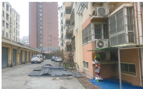
锦江花园小区4号楼南，钢管乱堆乱放。
