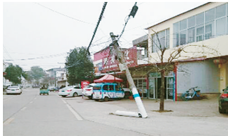
人民东路与东东北路交叉口向西约300米路北，通讯线杆断裂。
