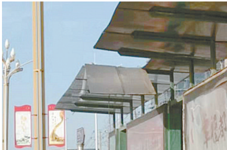
中山南路与湘江东路交叉口向南约30米，公交车停靠点顶棚破损。
