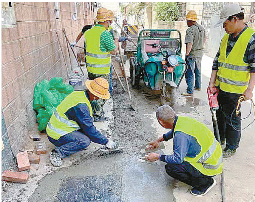
施工人员改造自来水管网。
