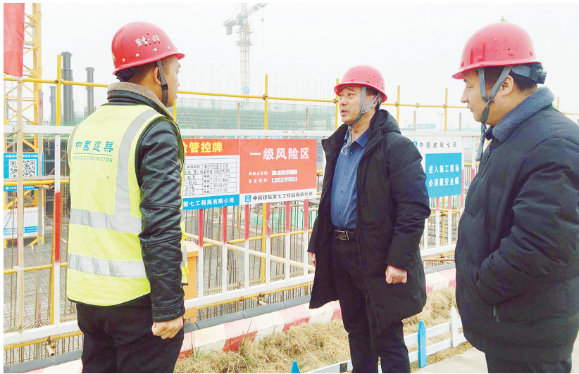
在市区一处建筑工地，刘智民（中）检查各项安全措施落实情况。
