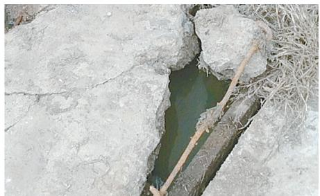
黄山小区25号楼北侧,污水盖板破损、钢筋裸露。
